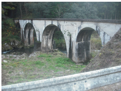
・土木学会選奨土木遺産認定のアーチ橋
