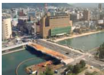
写真2：中の橋（太陽の橋）
