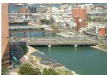
写真1：勝山橋（石の橋）
