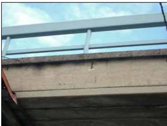
Photo8.鉄筋腐食による膨張でコンクリート塊落下
