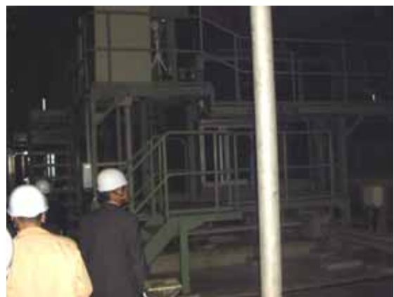
Photo4.生物反応槽周辺状況
