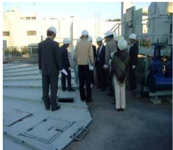
Photo3.最初沈殿地の屋上状況
