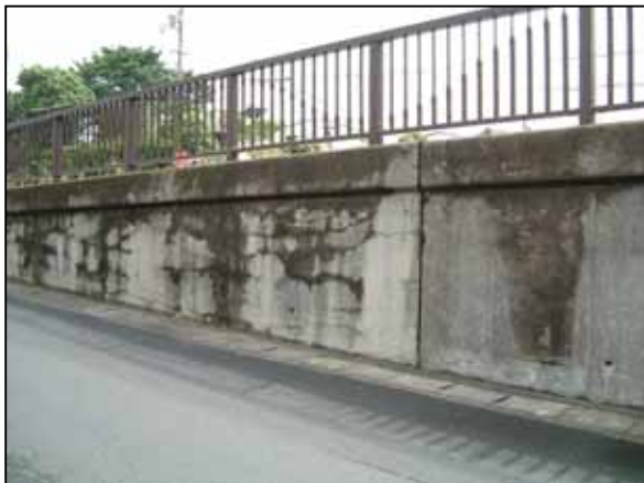
Photo7.アルカリ骨材反応事例
