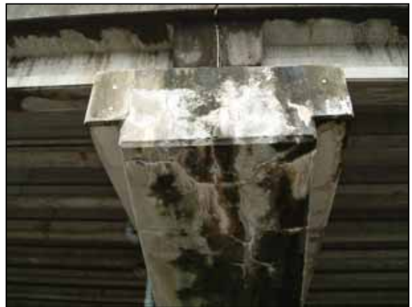
Photo7.アルカリ骨材反応事例
