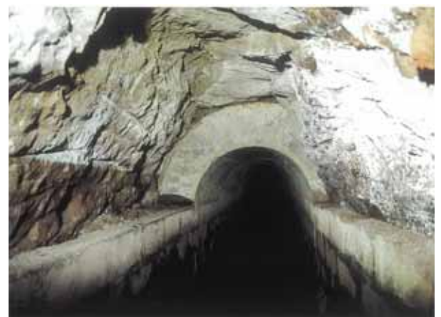
コンクリート補強部断面状況
