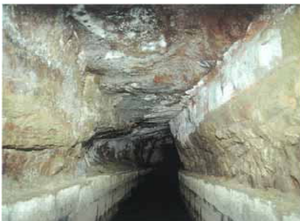
素掘断面状況
