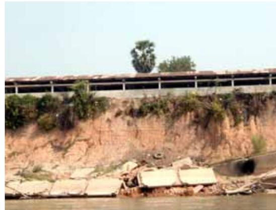
写真 護岸の破壊状況
