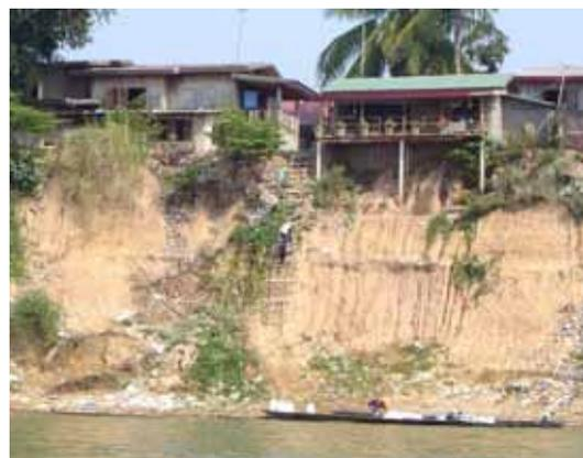
写真 ラオス側河岸の浸食状況
