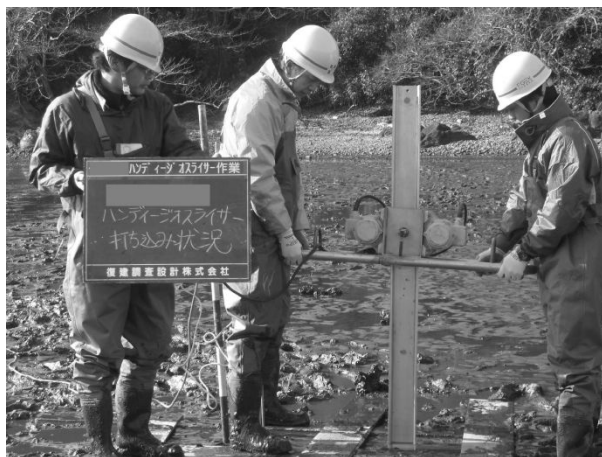
写真-3 地層抜き取り状況
