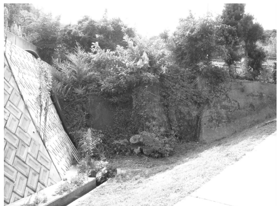
写真-6 津波石といわれる上遠田の「黒岩」 国道拡幅により削られたとのことである
