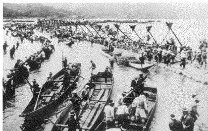
出雲結による水止め作業（昭和9年9月 出西村阿宮堤）
