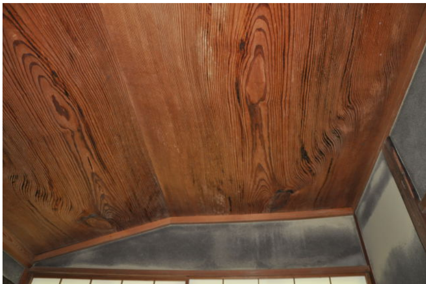
図-3. 萬寿寺・茶室 水屋の天井
