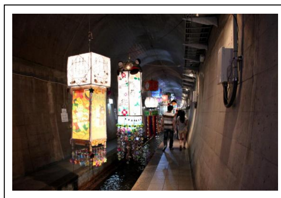
トンネル内の様子
