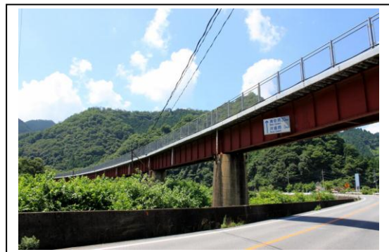
第八高梁川橋梁
