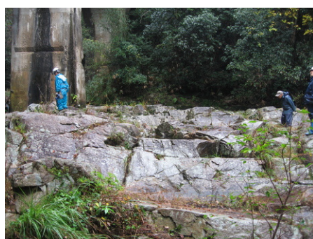
2 橋目 4 連アーチ橋の河川敷(岩畳)
