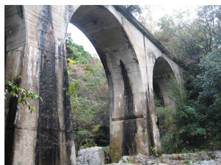
2 橋目 4 連アーチ橋
