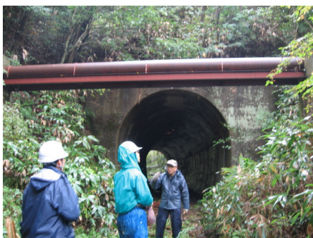
トンネル坑口の水管橋
