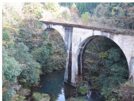
1 橋目 4 連アーチ橋 (新線より望む)
