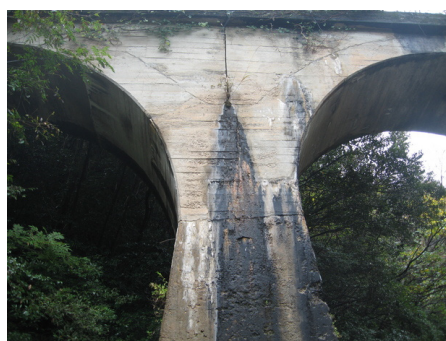
2 橋目 4 連アーチ橋
