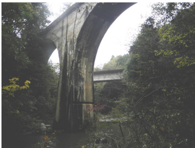
写真2：旧線の4連アーチ橋と新線の第一下府川橋梁
