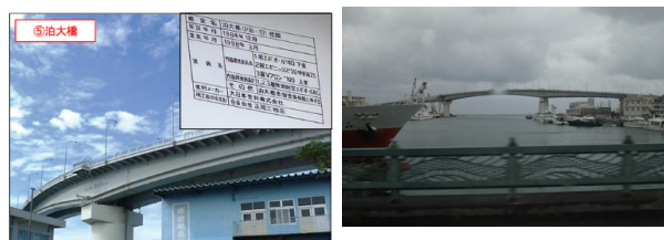
写真-7 『ほとんど海上橋』泊大橋
