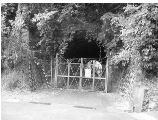
写真 9: 上府第一トンネル( L=35\text{m} ) 老朽化、変状が著しい
