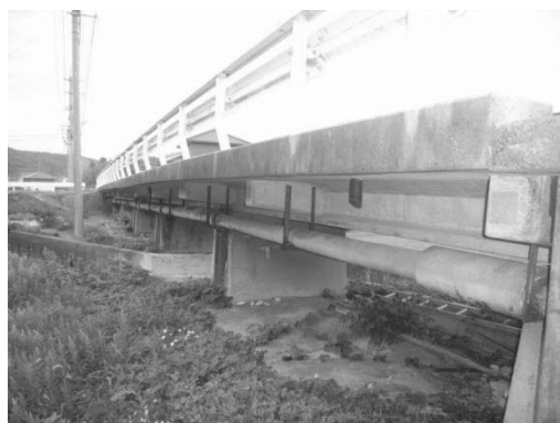
写真 8: 恩地橋(やたらと橋脚が多い)
