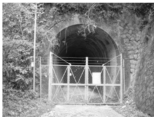
写真 10: 上府第二トンネル( L=365\text{m} ) 概ね健全
