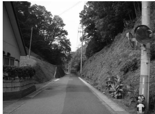
写真 4: 鉄道敷きを利用した道路(切土部)
