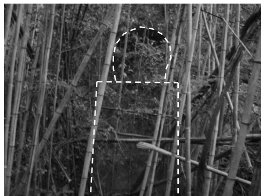
写真 12: 有福第二トンネル(L=54m)と橋台 竹林に覆われ、全く見えない。
