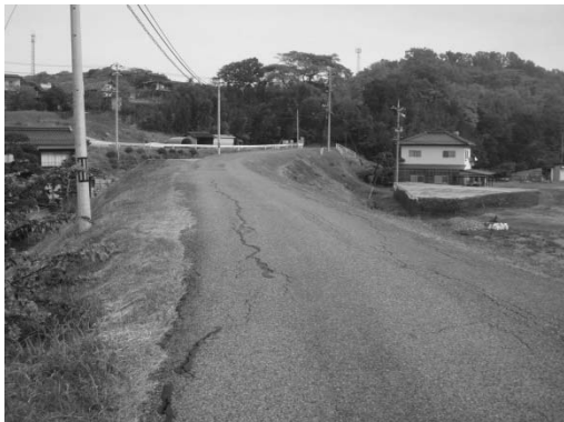
写真 3: 鉄道敷きを利用した道路(盛土部)
