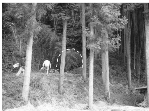
写真 11: 有福第一トンネル(L=220m) 杉林に覆われている。
