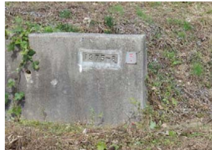
写真.4 コンクリート擁壁と境界プレート
