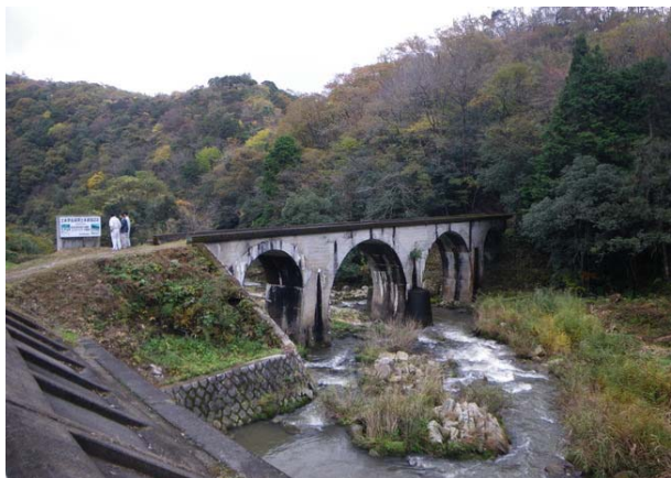
写真.9 4連アーチ橋(以前)
