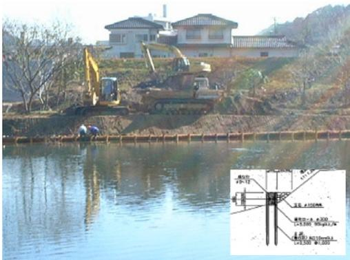
写真-2.6 植生ロール施工
