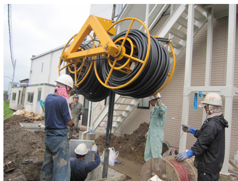
図-3 施工風景(Uチューブ挿入)
