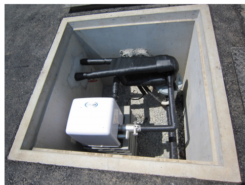
図-4 ヒートウェル式熱交換井
