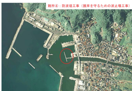
難所④：防波堤工事（護岸を守るための波止場工事）
