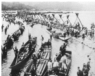
出雲結による水止め作業(昭和9年9月 出 西村阿宮堤)
