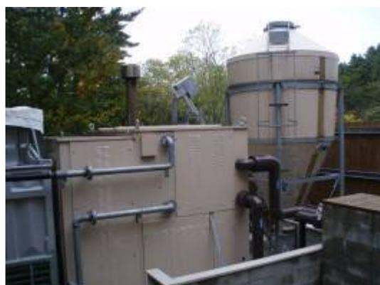
図表-21 ペレット焚き空調システム全景
