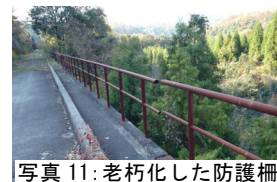
写真11：老朽化した防護柵
