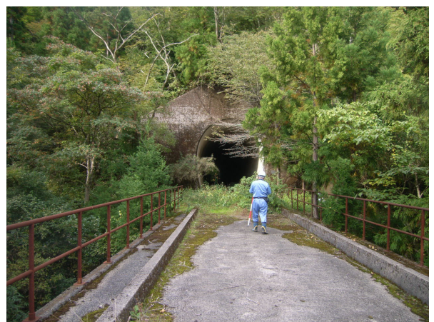
写真 6：新線の旭町丸原の橋梁及びトンネル 木が生茂り、外部からはほとんど発見できない。
