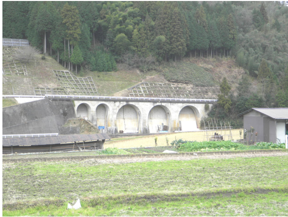
写真 3：旧線のアーチ橋を生かした県道を正面から望む。アーチ橋は完成後、70年以上経過している。
