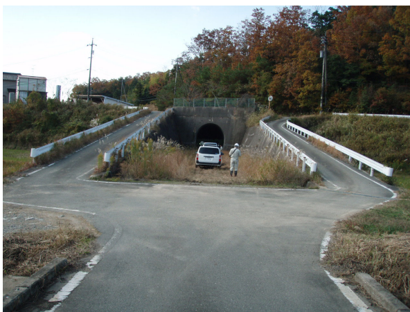
写真 5：新線の下長屋トンネル（約 L=1.6\text{km} ）を今福側から望む。トンネルを含めて L=2\text{km} 以上がほぼ直線区間である。
