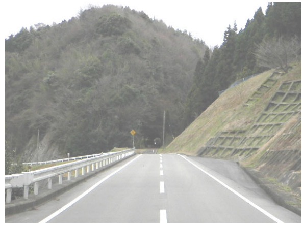
写真 4：写真 3（アーチ橋上）を道路上から望む。左車線の路肩～中央までがアーチ橋。正面奥は鉄道のトンネルで、県道はトンネル手前を右下に下る。
