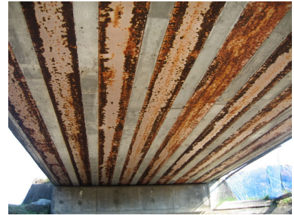
RC床版橋（下今福）鋼板接着補強
