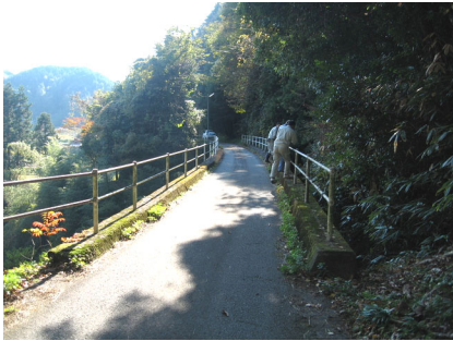
道路として使用（アーチ橋部）
