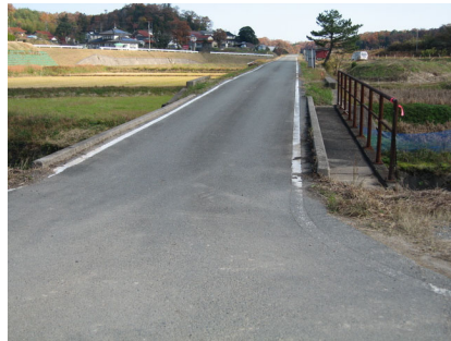
道路として使用（RC床版橋部）
