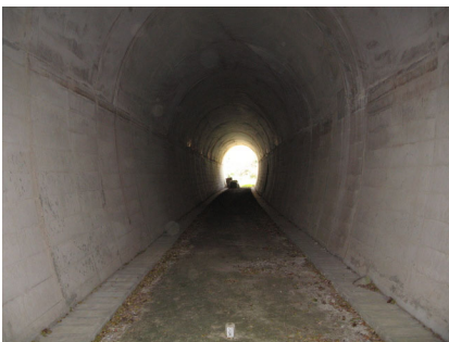
トンネル（御神本）内状況：側溝（蓋有）
