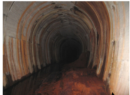
今福第1トンネル内状況
