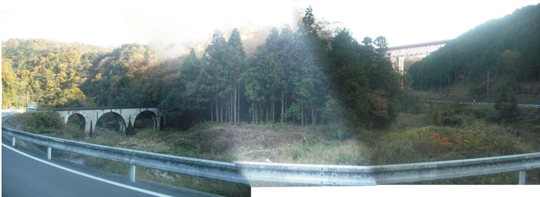
【↑4連アーチ橋。左隅に銘板が見える】
