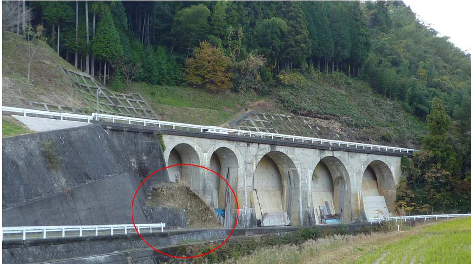
基礎岩盤（風化している）部が崩壊
