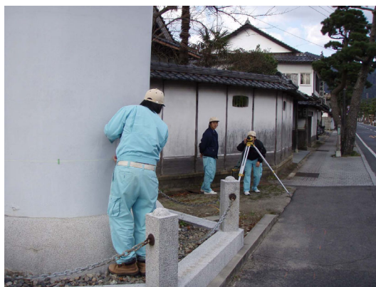
写真 1 実施訓練（測量実施状況）
