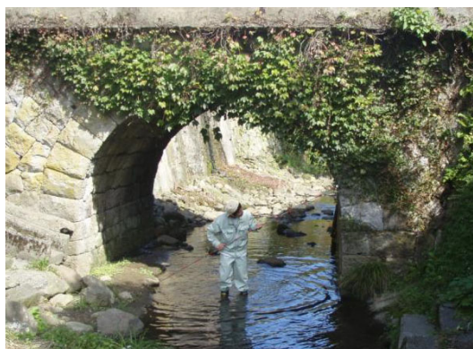
写真 2 羅漢町橋の測量状況
