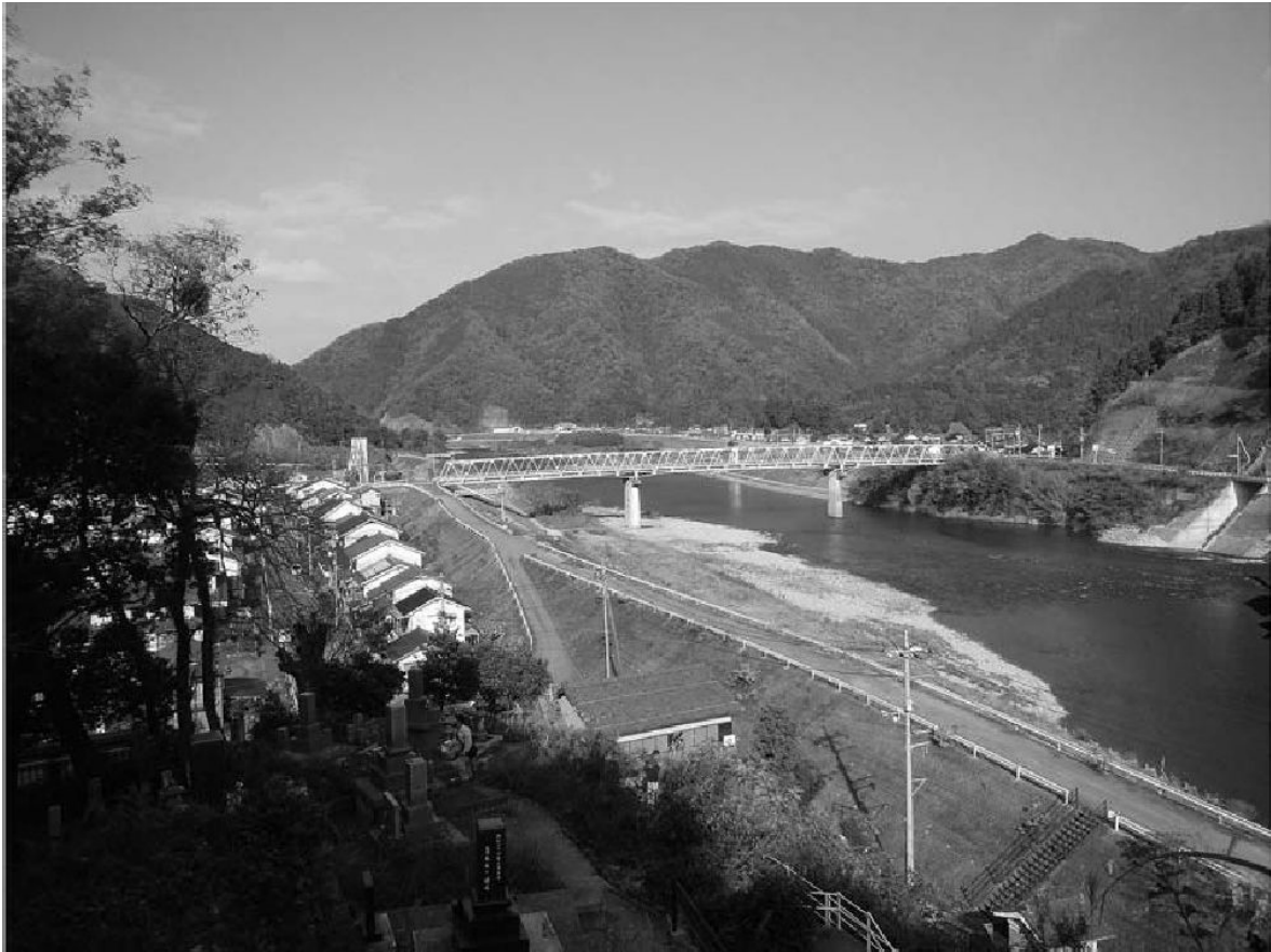
写真-1 桜江大橋（よく見ると桜江大橋は改築されている）
