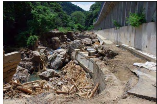
写真 写真-2 箇所を下流側から見る
