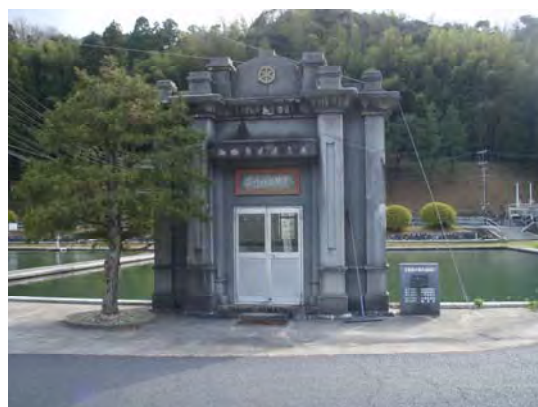
写真3 1号ろ過調整井室
