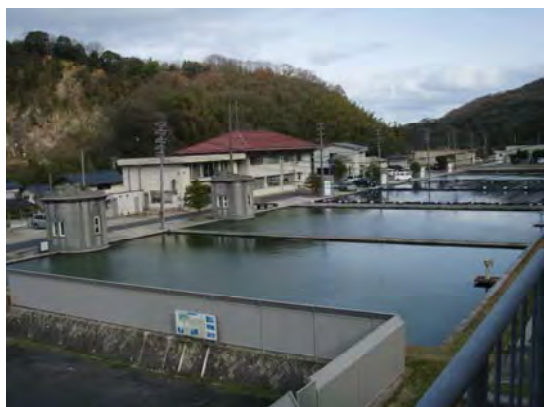
写真2 1～6号緩速ろ過池全景
