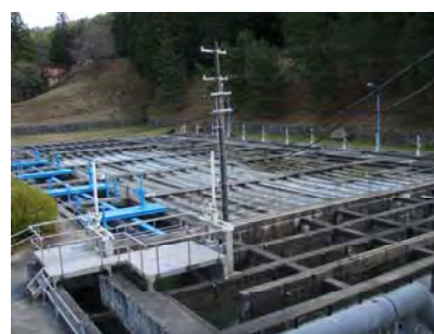
写真 5 フロック形成池 及び沈殿池
