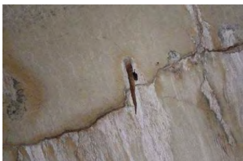
写真6：コンクリートのつらら
