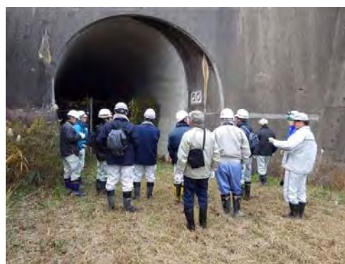
写真3：いざトンネル中へ
