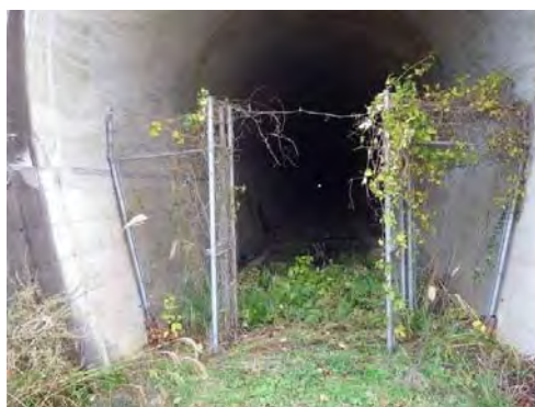
写真2：開かれし門扉
