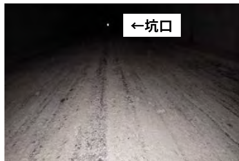
写真9：線路敷の路盤
