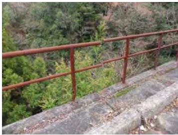
第一下府川橋梁防護柵破断
