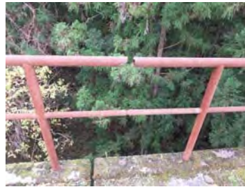
第二下府川橋梁防護柵破断
