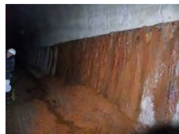
漏水、土砂流入
