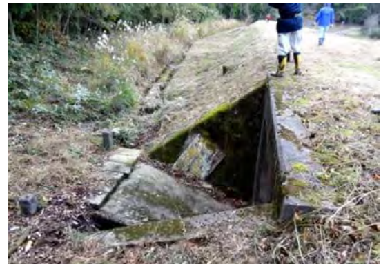
旧線の路盤跡
