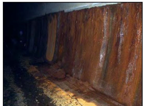
写真 4：側壁の目地から土砂流出
