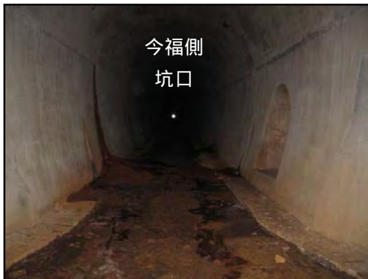
写真 1：断面変化（トンネル中間地点）
