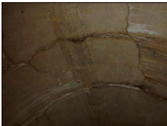
写真 3：クラック（天井部）
