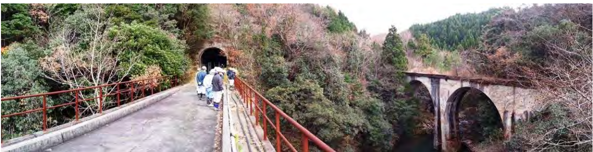
図5 旧線（写真右側のアーチ橋）と新線（写真左側）が並走する様子
