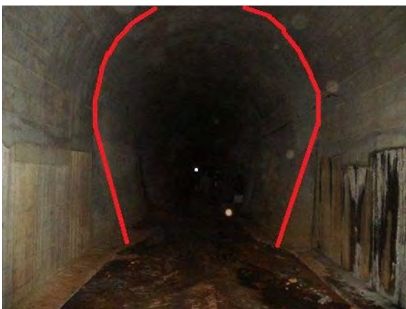
図4 馬蹄型及び側壁直型の変更点
