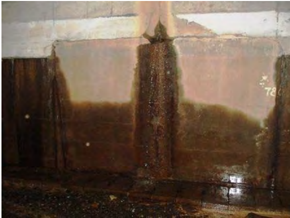
図3 トンネル内湧水の様子
