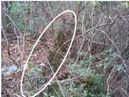
a) コンクリート擁壁（新線）
