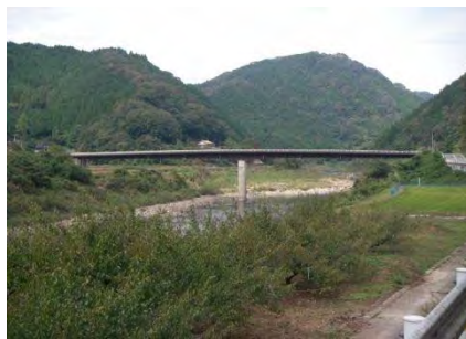
No.6 宇都井大橋 (鋼床版箱桁橋)
