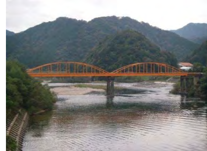
No.12 都賀行大橋 (ランガー橋)
