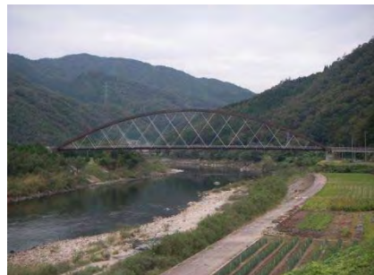
No.9 大浦橋 (ニールセンローゼ橋)
