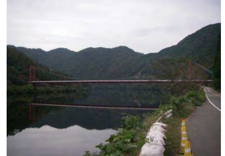
No.13 信喜橋 (吊り橋)
