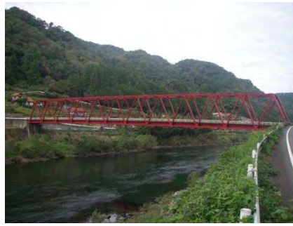
No.2 丹度橋 (トラス橋)
