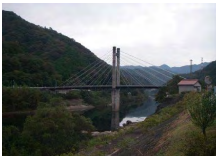
No.11 高梨大橋 (斜張橋)
