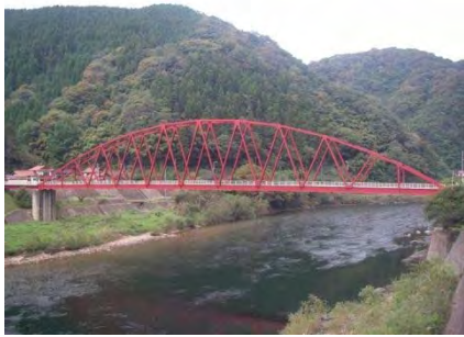
No.1 三国橋 (トラスランガー橋)
