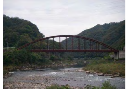
No.10 大和大橋 (パイプローゼ橋)
