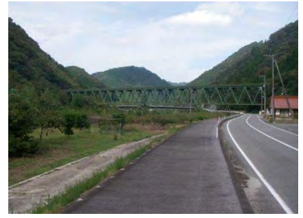
No.5 第三江川橋梁 (トラス橋・鉄道橋)
