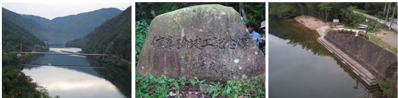
写真3.2 信喜橋の状況
