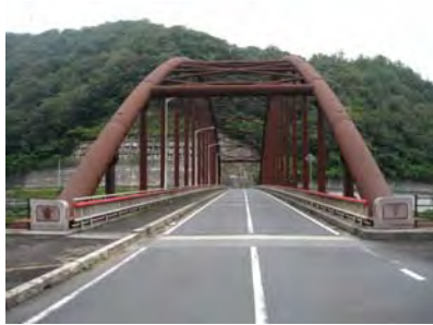
a) 圧倒するパイプ
