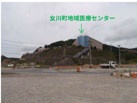
P.20 のり枠上にある女川町地域医療センター 医療センターの標高は 15m。
