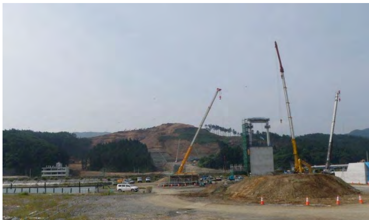
P.2 今泉地区約 42ha の高台移転事業 一山を掘削するほどの大規模な土工が行われていた。
