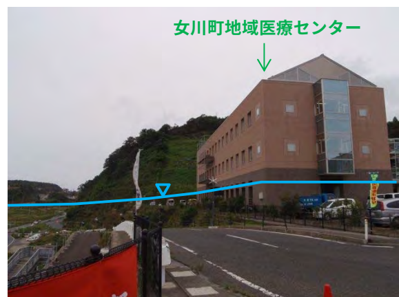
P.21 津波が遡上したと考えられるライン 津波は医療センターの 1 階まで到達している。
