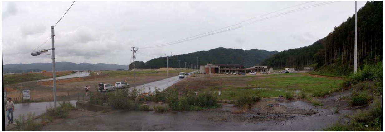
写真-8 高台から旧大川小学校を望む
