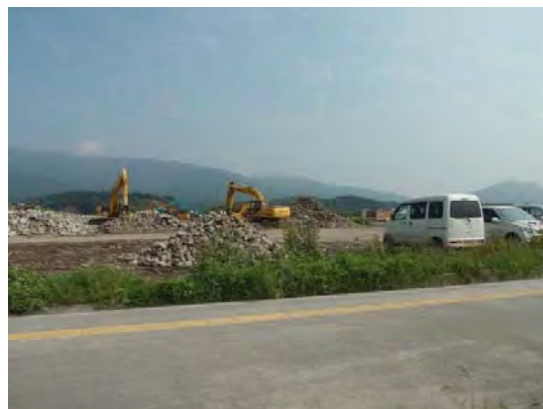
写真-2 瓦礫処理する重機
