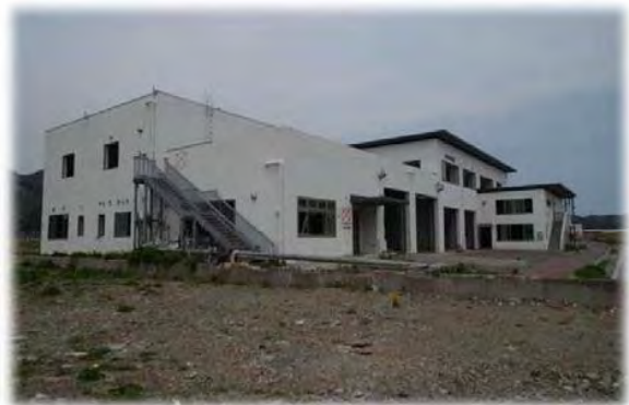
写真-11 鵜住居地区防災センター跡
