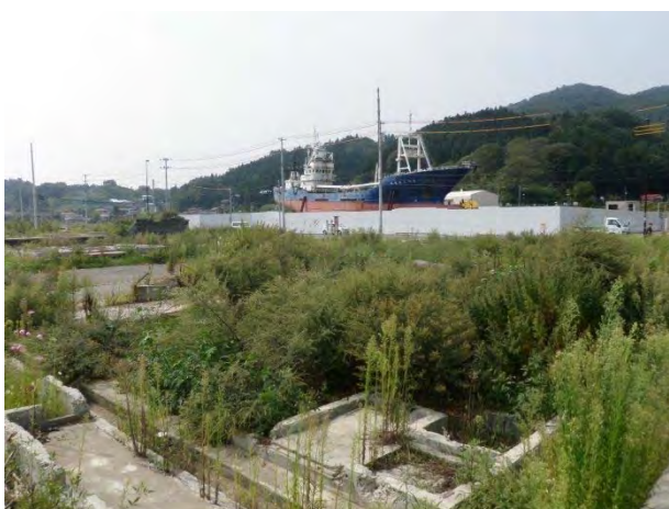
打ち上げられ船体と 建物基礎
