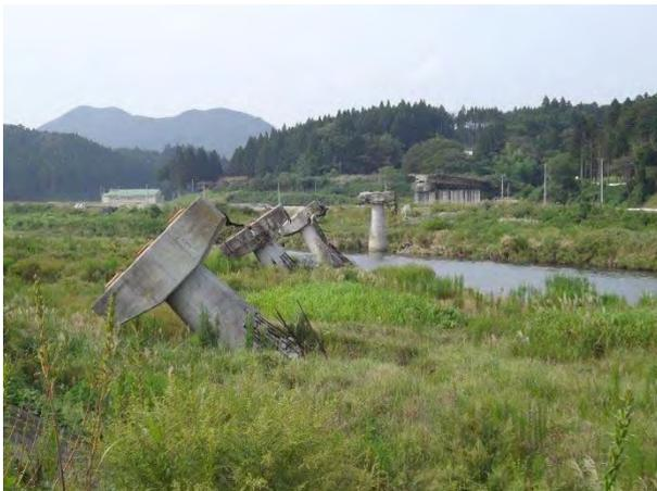
写真 3 津波によって傾いた高架の橋脚
