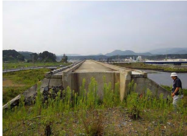
写真 2 線路が流出した路線の跡
