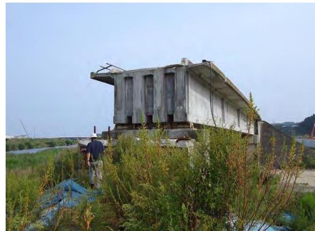
写真 4 橋台。橋桁は流失している。
