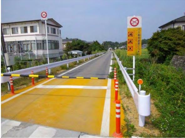
写真 5 線路を舗装したバス専用道
