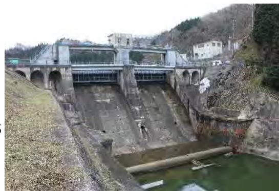
写真-1 阿井川ダム
