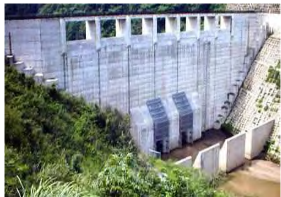
写真-5 益田川ダム（島根県HPより）
