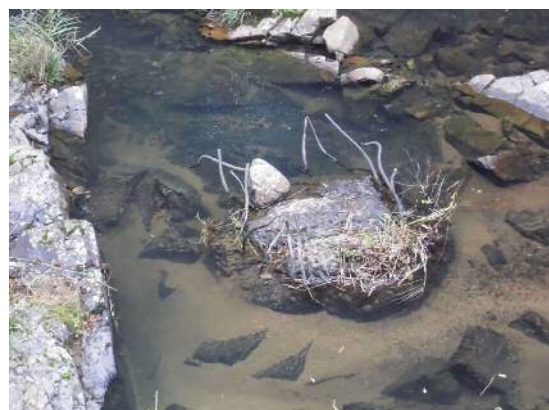
下府川の河床に確認出来る橋脚跡(拡大)
