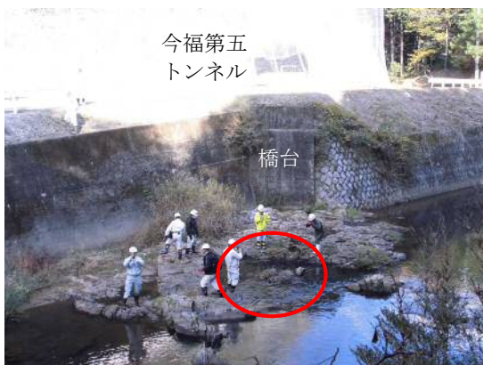
下府川の河床に確認出来る橋脚跡(赤丸)
