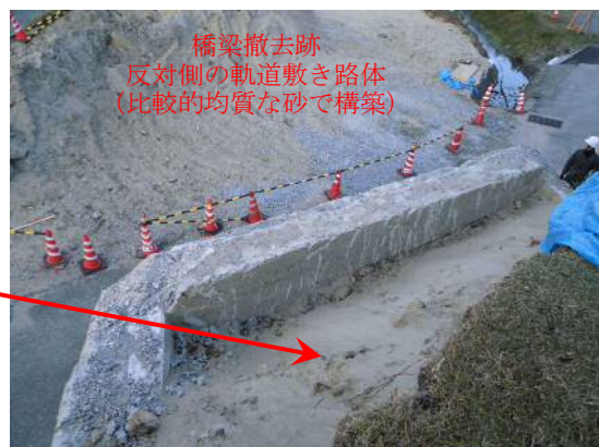
下府橋梁背後の軌道敷き路体(拡大)
