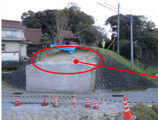
下府橋梁背後の軌道敷き路体(赤丸)
