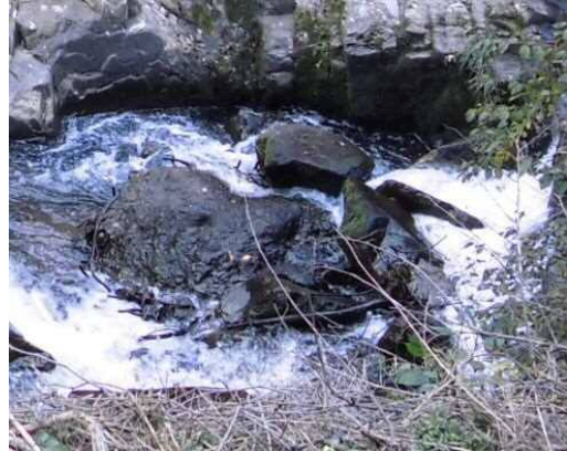
下府川の河床に確認出来る橋脚跡(拡大)
