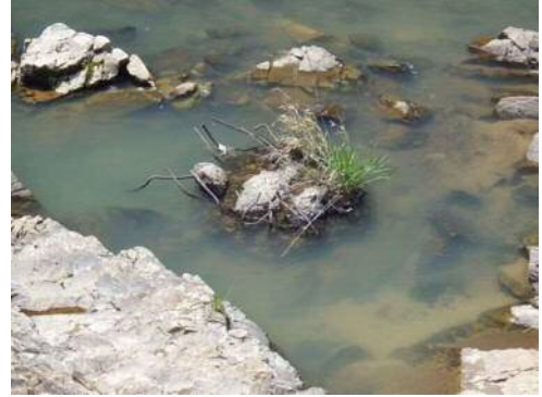
写真6：今福第五トンネル上流側
