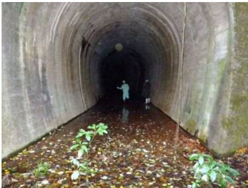
写真7：今福第一トンネル
