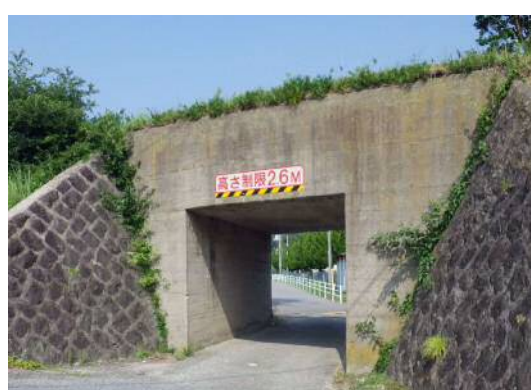
写真. 4 下府橋梁(取り壊し前)
