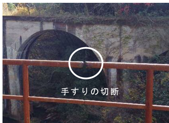
写真.2 手すりの老朽化
