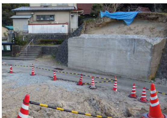
写真. 3 下府橋梁(取り壊し中)
