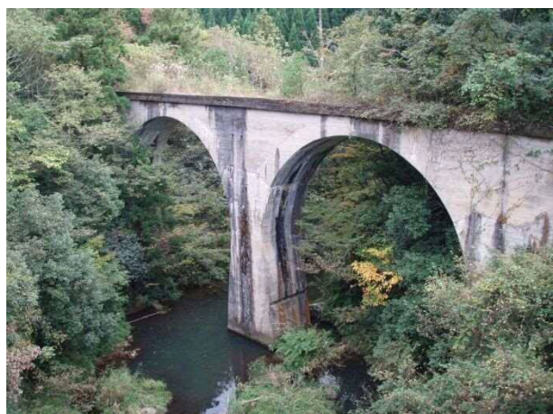
写真 9: 第1下府橋梁から見る旧線の4連アーチ橋。この先にも4連アーチ橋があと2橋ある。
