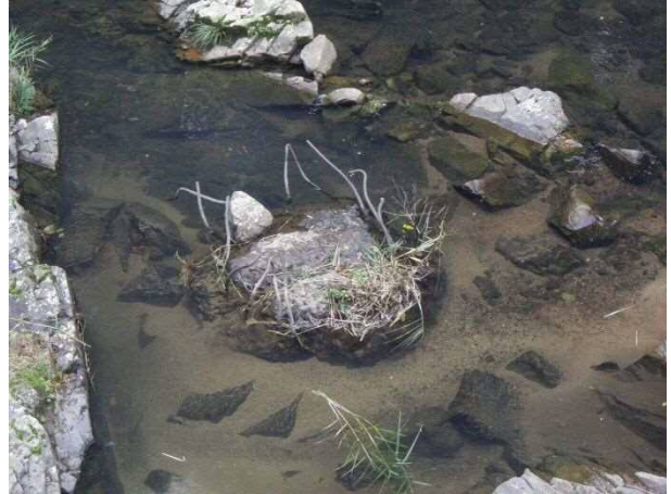
写真 6: 河床に発見した橋脚の基礎部。鉄筋が引きちぎられたように残る。
