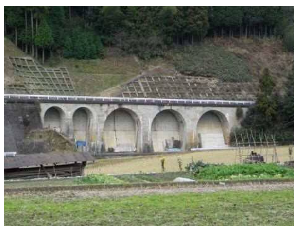
写真 4: 県道として利用されている5連アーチ橋
