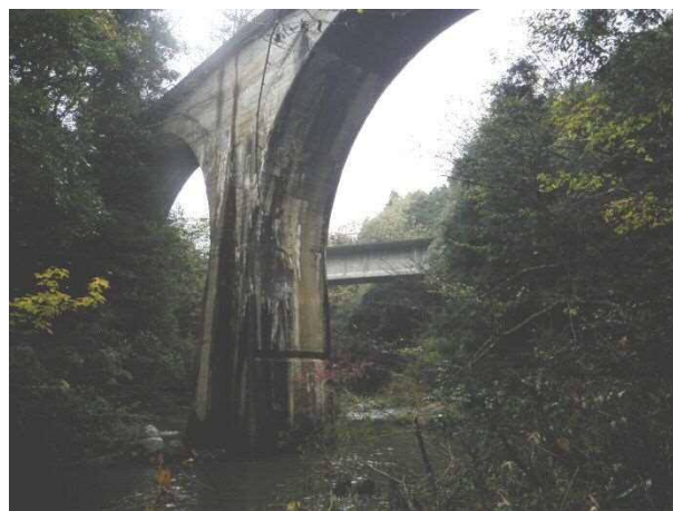
写真 10: 旧線の4連アーチ橋を川から見上げる（奥は第1下府橋梁）。
