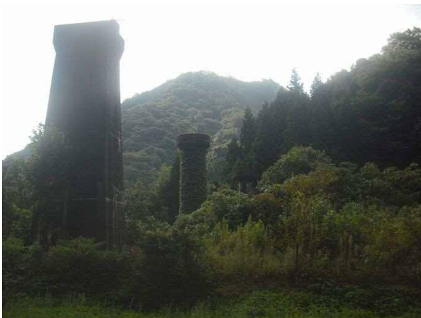
写真 1: 県道から見た橋梁群
