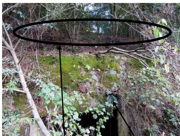
軌道敷き 床版橋
