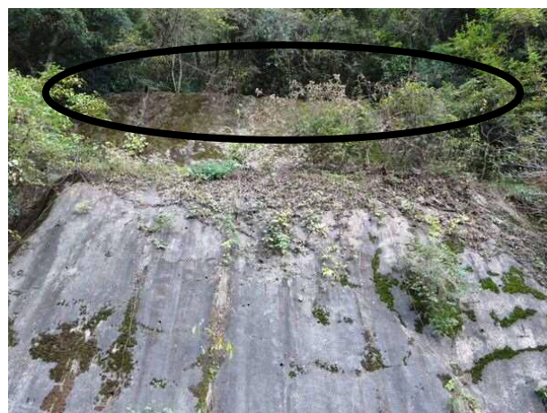
図3.4.6 法面上の軌道敷き
