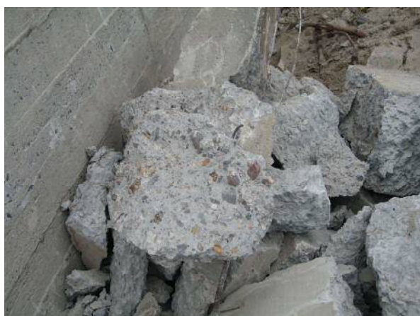
図 3.3.9 コンクリートの状態
