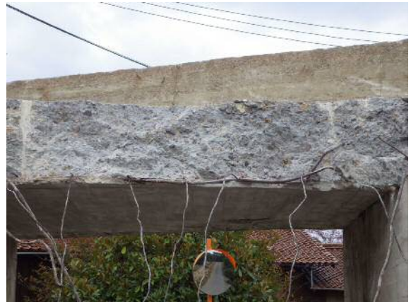
図 3.3.8 床版断面写真（鉄筋は下面のみ配置）
