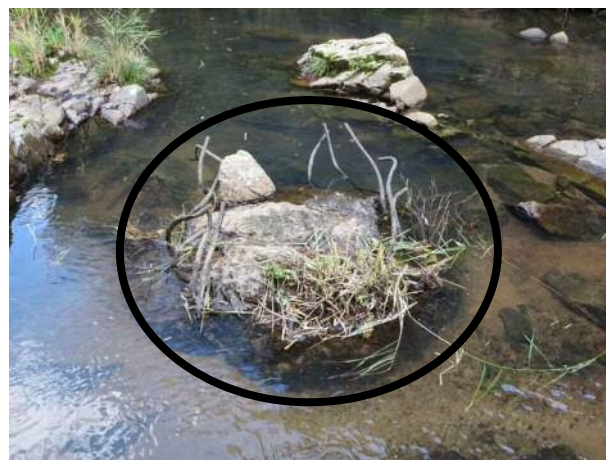
図 3.4.2 橋脚跡（上流側）
