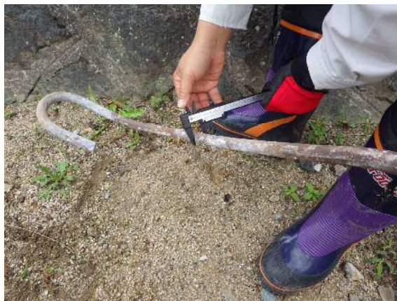
図 3.3.9 床版内の鉄筋写真（丸鋼）
