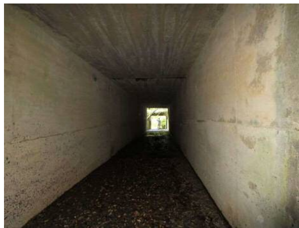
図 3.4.9 床版橋の内空状況
