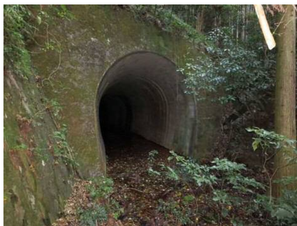
図3.4.4 今福第1トンネル坑口（下府駅側）
