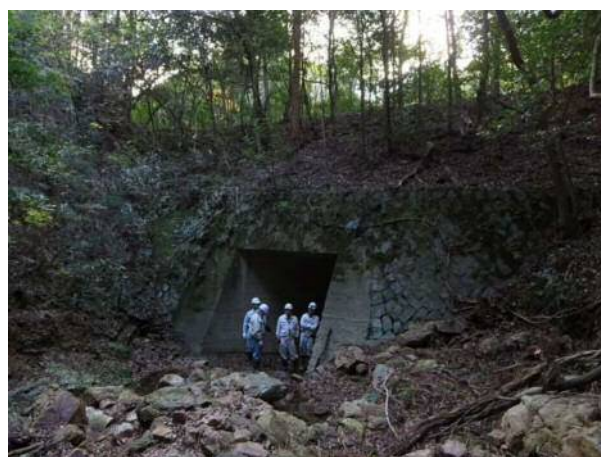
図 3.4.8 床版橋の呑口
