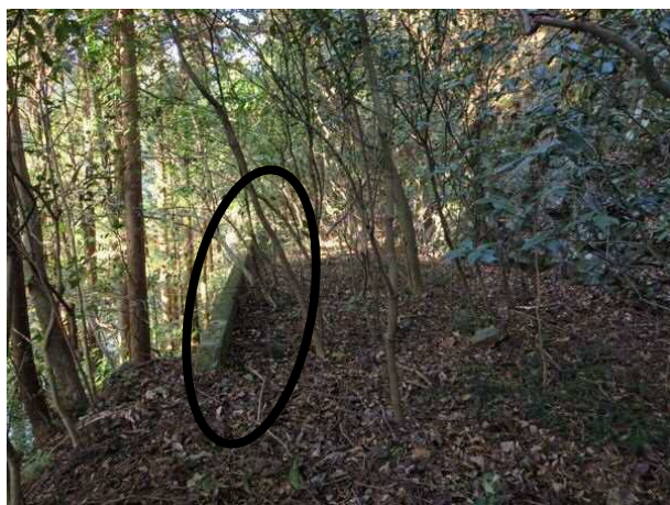
図3.4.3 コンクリート擁壁
