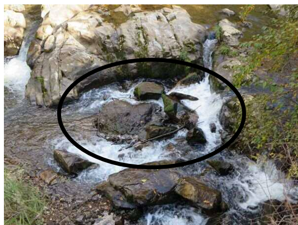
図 3.4.1 橋脚跡（下流側）
