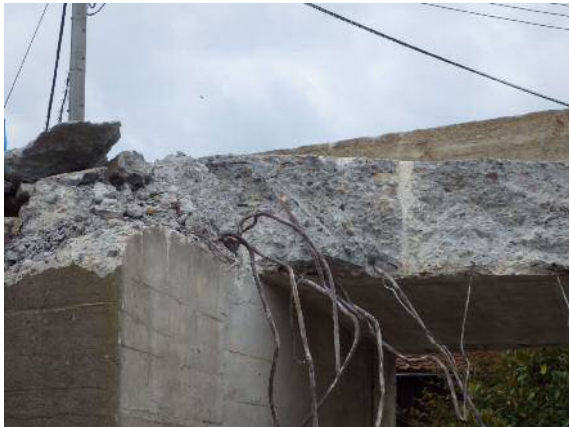
図 3.3.8 床版断面写真（鉄筋は下面のみ配置）
