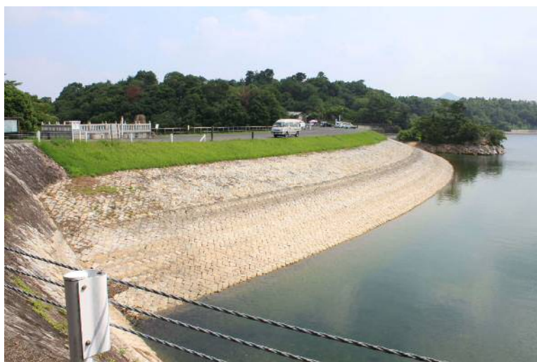
写真-2 満濃池上流面写真（左岸）
