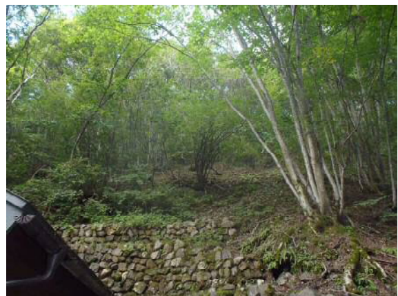
写真 4 鷹狩風穴小屋上方斜面
