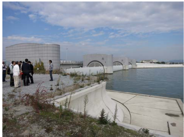
写真 3 平成 26 年度 岡山県支部交流 百間川新水門視察
