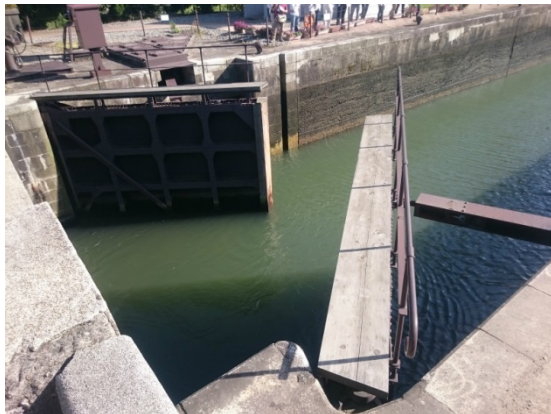
閘門開閉状況
